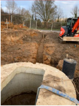
ROAD GULLEY DIG
