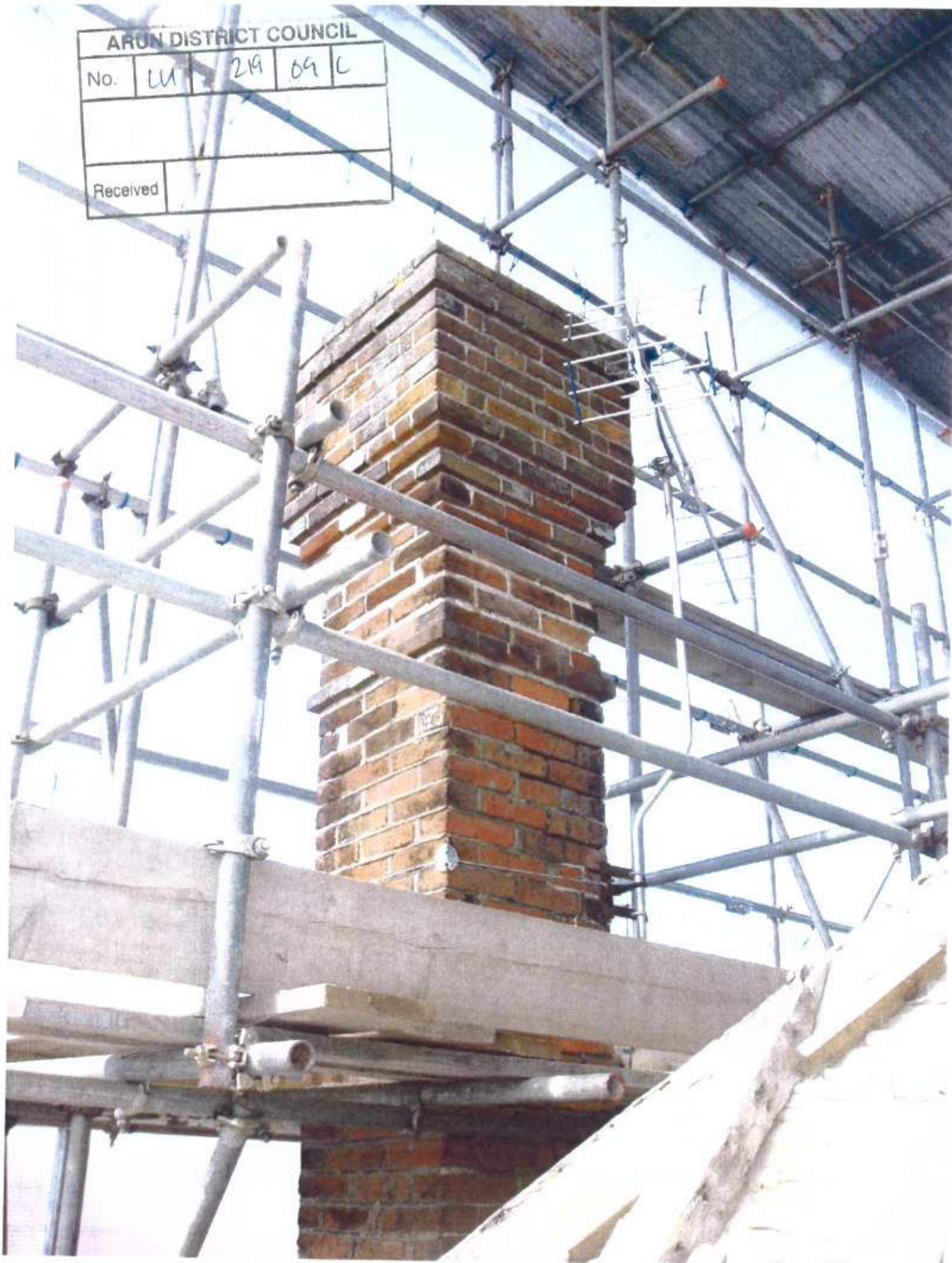
TOP SECTION OF CHIMNEY N°3
