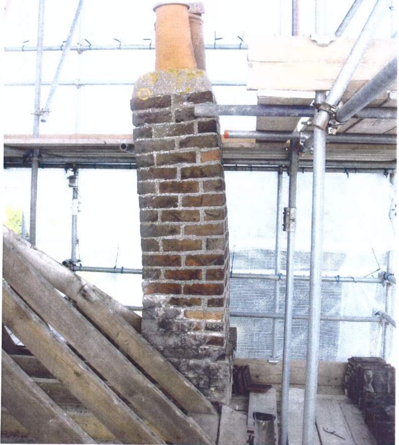
EXISTING CHIMNEY N°1
