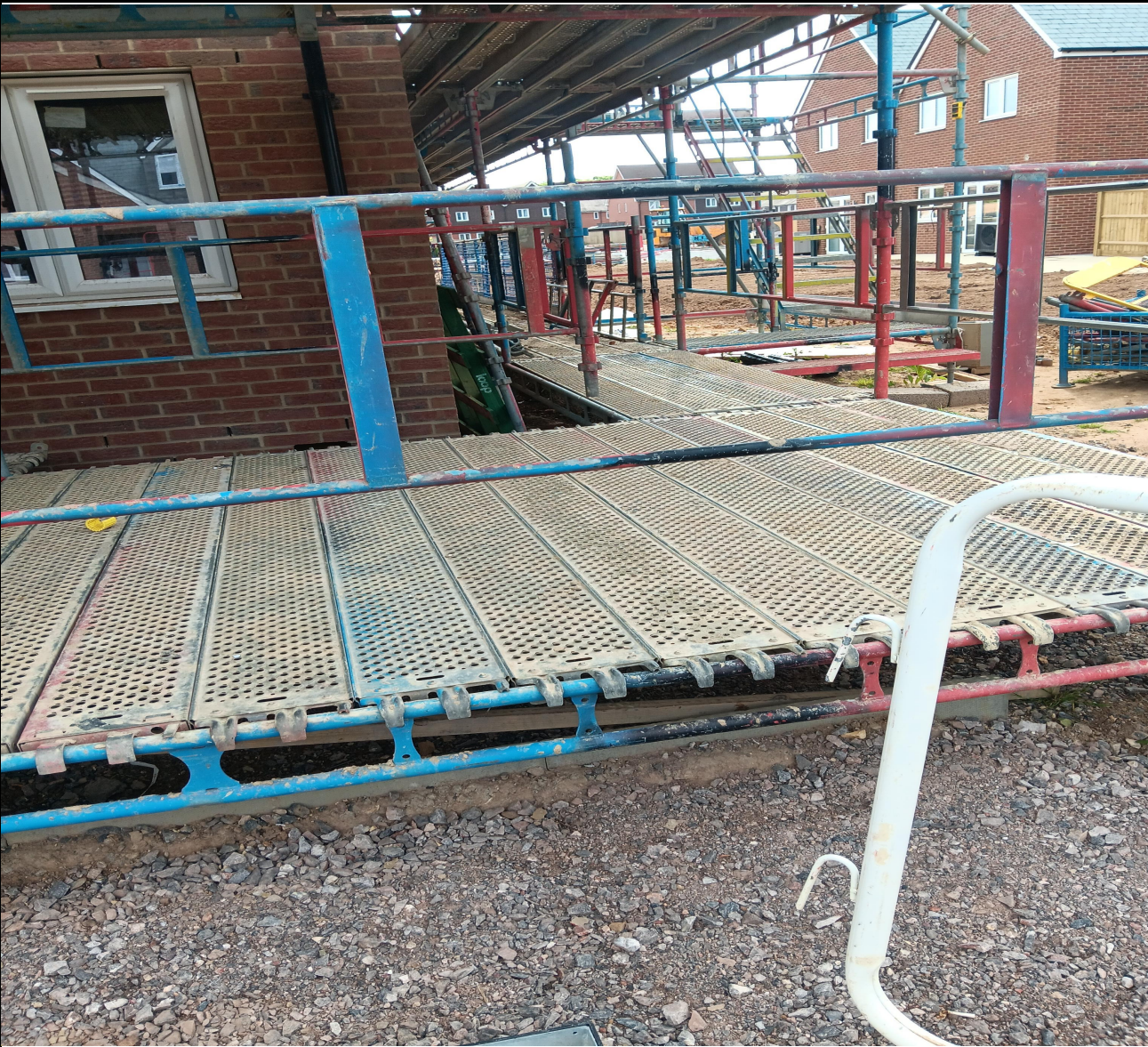
MANHOLE PPCP 6 UNDER SCAFFOLD
