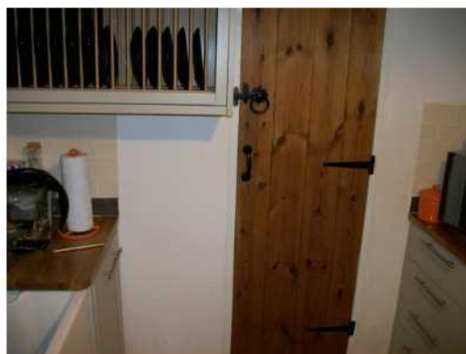
Existing cloakroom door
