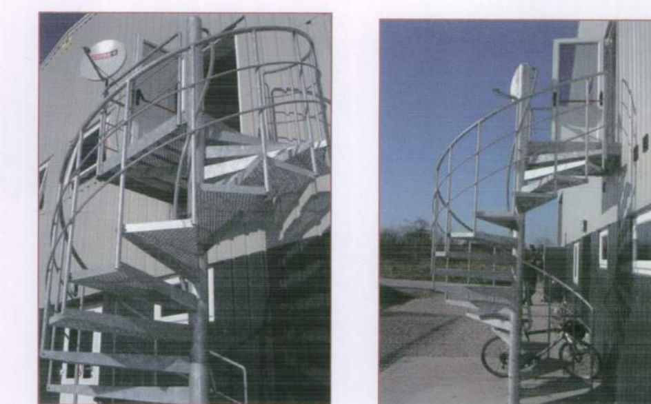
TYPICAL FIRE ESCAPE n.t.s.
