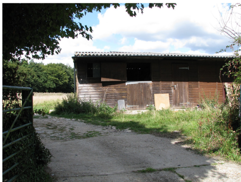
2178 - Stables: Timber framed & clad; Concrete apron.
