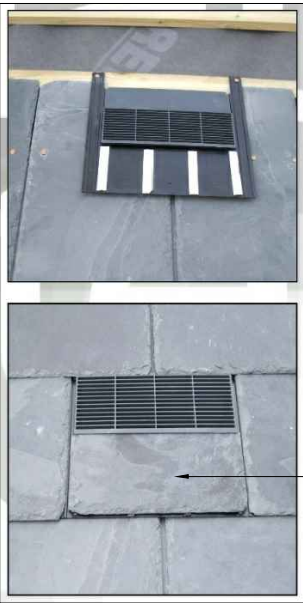
Example of natural slate vent n.t.s.
