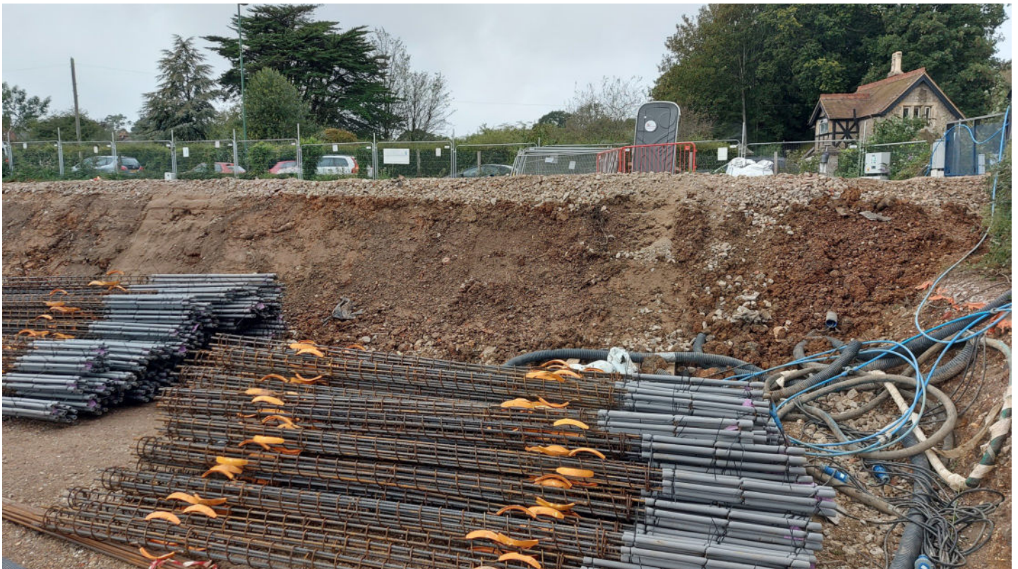
Photo 10. Pile Mat Cells F1 and F2 (19/09/2023).
